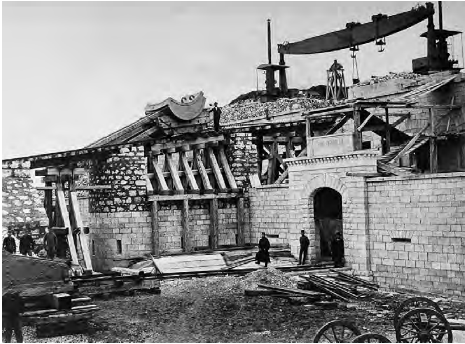
Trasporto di piastre di armatura per la costruzione del forte Verudella, 1885 (Fonte: Museo storico dell'Istria).
