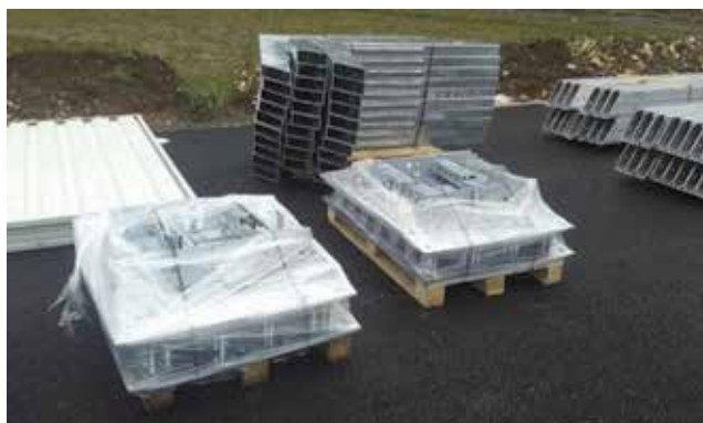
Slika 17. Skladištenje predgotovljenih elemenata na gradilištu
