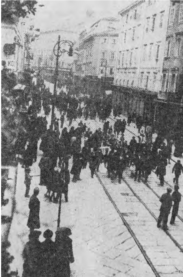
Dimostrazioni a Trieste dopo il crollo dell'Impero austro-ungarico
