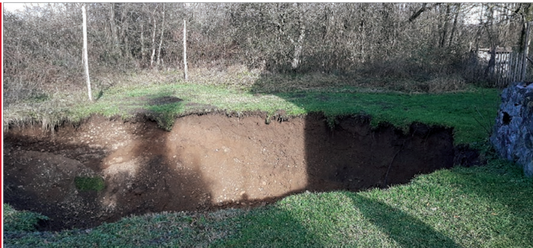
Sl. 11. Ponikva na području sela Mečenčani. Na desnoj strani fotografije vidi se zid kuće do koje se ponikva proširila. Kuća lagano tone u tlo. foto: Marija Ros Kozarić
