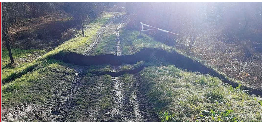
Sl. 12. Nasip u selu Palanjek – puknuća i uleknuća te odranjanje nasipa. autori: Matea Mihić, Danijela Konjević, Ivan Kostelec
