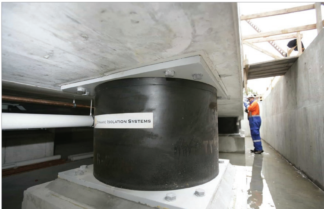
Sl. 5: Primjer bazne izolacije zgrade
