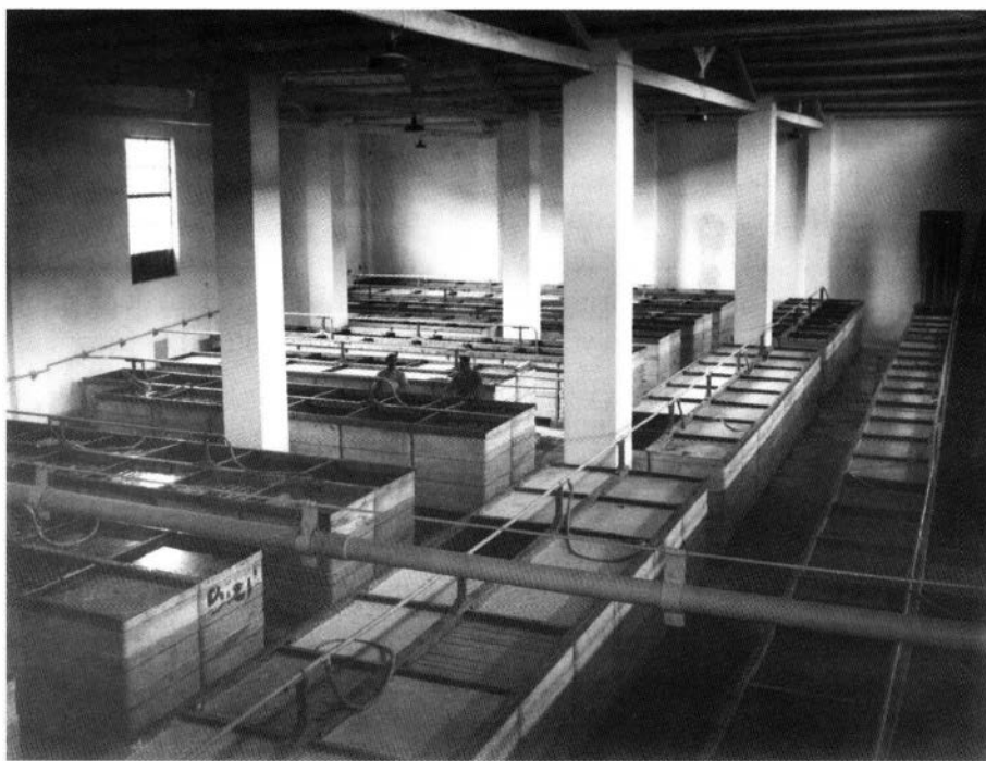
Nuovi impianti nell'industria conserviera di Isola (ARC, f. 334, Fototeca)
