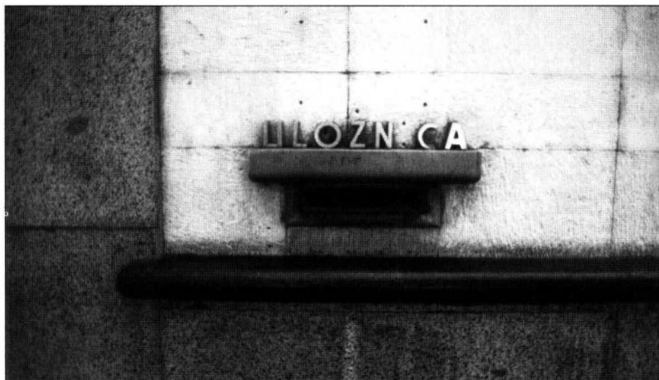
A. Mazzoni, Pola, Palazzo Postale. Particolare all'esterno, presso l'accesso, dei materiali costruttivi impiegati: pietra d'Istria martellinata, granito, monsonite; 1999.
