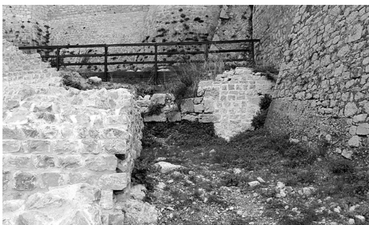
11 Kaštel sv. Mihovila, sjeveroistočni podzid nakon obnove (foto: I. Glavaš)
