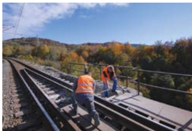
Slika 2. Održavanje željezničke infrastrukture (Izvor: [6])
