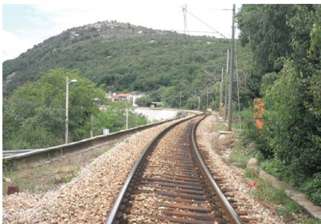
Slika 3. Pružna dionica na ulazu u Drage
