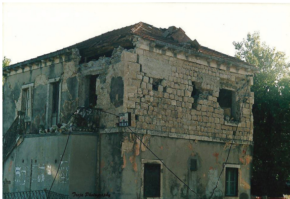
Slika 1 Jedna od građevina nakon potresa u Stonu (Trojanović, 1996). Epicentri niza potresa Ston-Slano 1996 (Markušić et al 1998)
