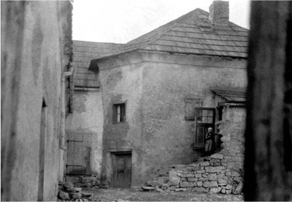
UDBINA, kuća (džamija), pogled s dvorišne strane; Većeslav Heneberg, 1933. (MKM – FKB, inv. br. 7827, br. neg. III-796)
