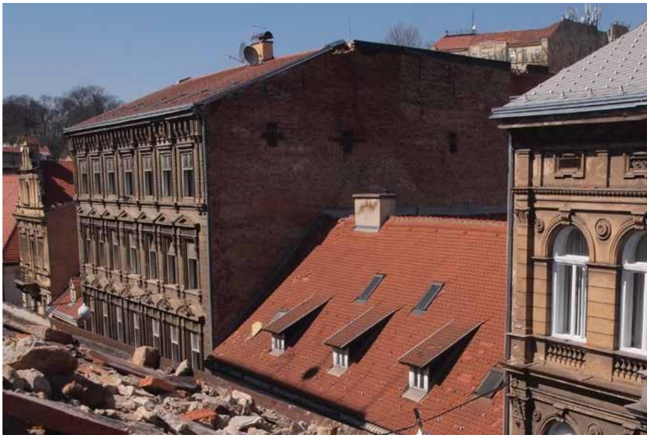
3. Franjo Klein, Kuća Sollar u Ilici 16 nakon potresa od 22. 3. 2020. s i danas jasno vidljivim željeznim zategama na vatrobranom zidu (foto: Dragan Damjanović, 2. 4. 2020.)
