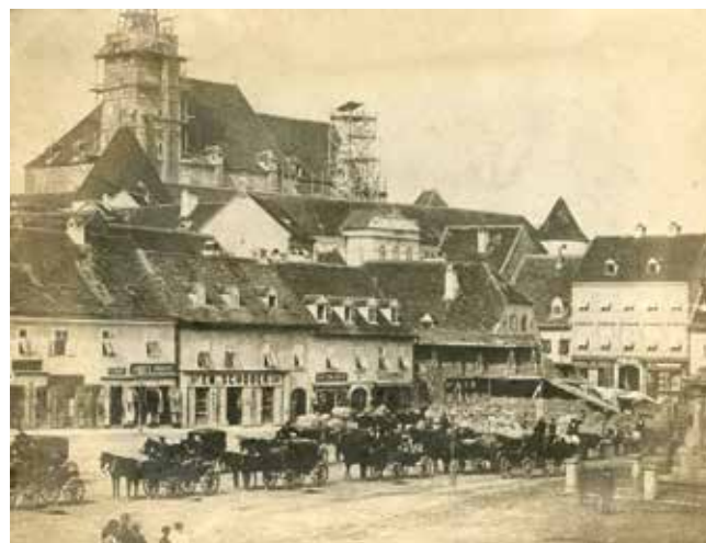
10. Početak gradnje kuće Baumgärtner, proljeće 1881. (MGZ, fot. 1724)
