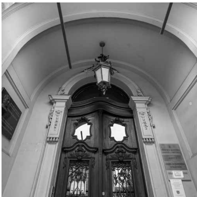
20. Glavni portal Main portal
