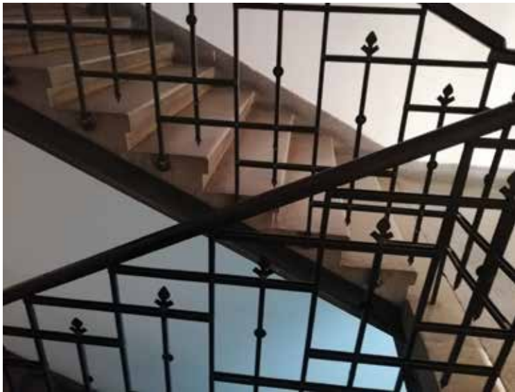
8. Stubište s ogradom u Ivekovićevoj zgradi (foto: Irena Kraševac, 2020.)
