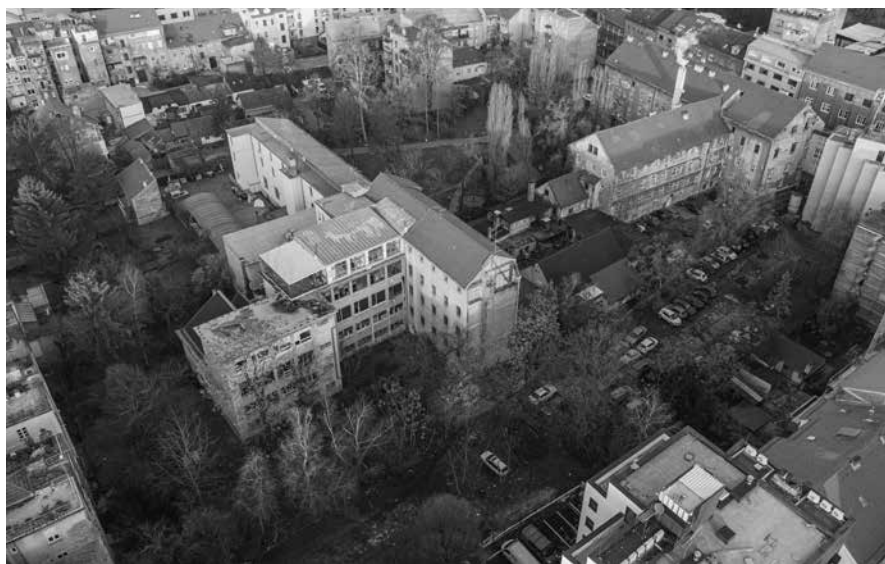
14. Blok s kompleksom zgrada Akademije likovnih umjetnosti u Zagrebu, pogledi iz zraka (foto: Paolo Mofardin, 2020.) Aerial views of the building complex of the Academy of Fine Arts
