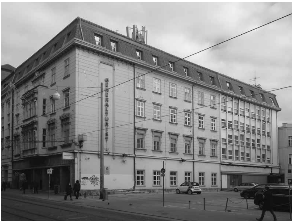
18. Južno pročelje kuće Frankl s dogradnjom iz sedamdesetih godina 20. stoljeća, 2020. View of the south façade of the Frankl house with 1970s addition, 2020
