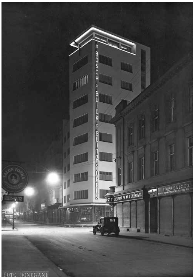
11. Foto Donegani, Stambeno-poslovna zgrada Radovan, arhitekta Slavka Löwyja, Zagreb, Masarykova 22, snimljeno 1934. (privatno vlasništvo)
