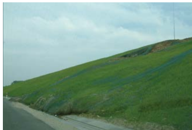
Slika 2. Klizište na prirodnoj padini s nagibom od oko 25°, osigurano geotekstilom/geopletivom za kontrolu erozije bez čavljanja
