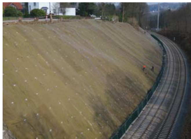
Slika 12. Osiguranje pokosa nakon odrona na trošnoj stijeni
