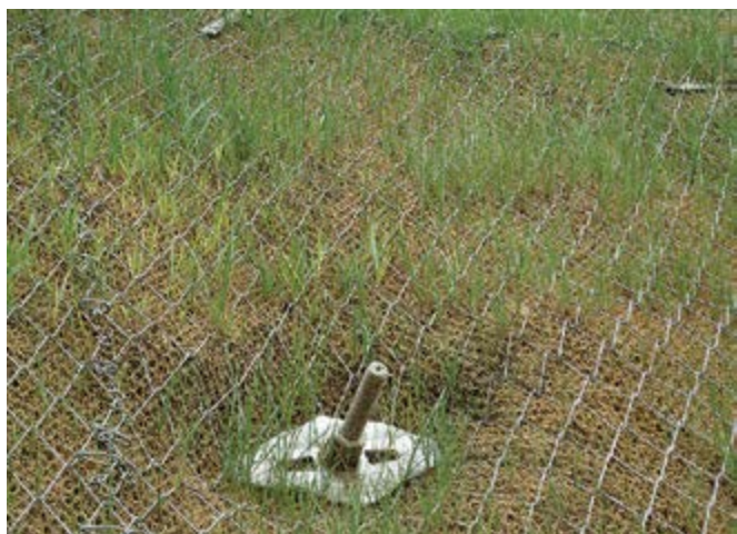
Slika 10. Geopletivo za kontrolu erozije TECMAT® u kombinaciji sa žičanom pletenom mrežom od čelika visoke čvrstoće TECCO® G65/3 na području s čavljanjem tla
