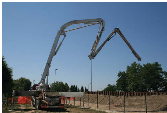
Slika 6. Izgled pumpe prilikom istovara betona [2]
