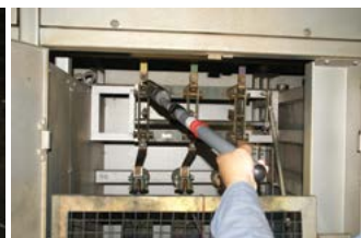
Slika 4. Pravilan način ispitivanja napona [2]
