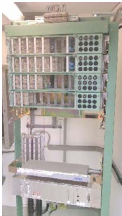
Slika 7. Relejni stalak s relejnim grupama, brojačem osovina i TNS++
