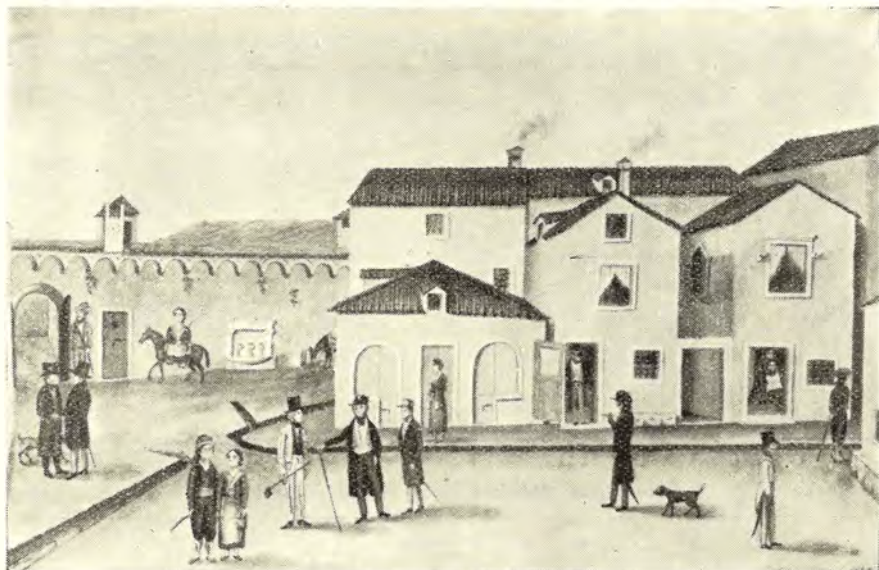
Barač: Trg i dio zidina Stona iz prve polovice 19. st.
