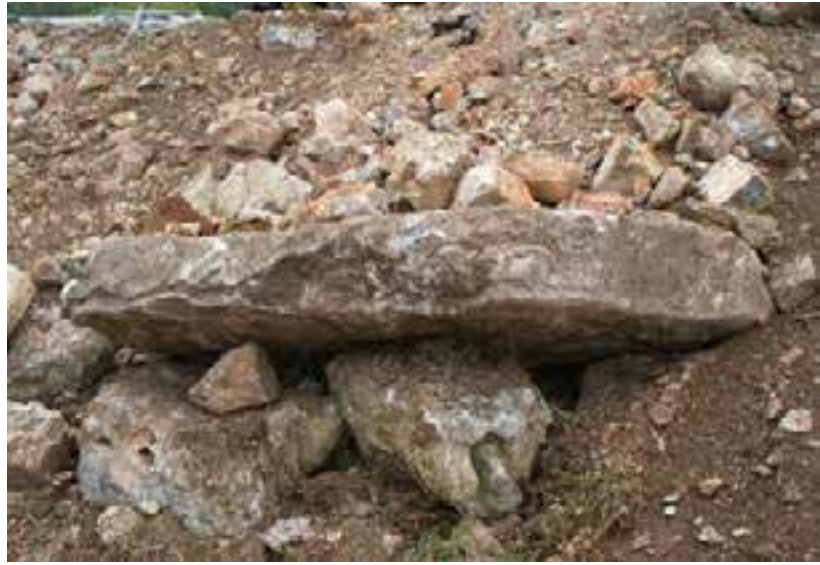
Sl. 5. Izbačena kamena poklopnica u zapadnom kanalu Fig. 5 Ejected stone cover in the western trench
