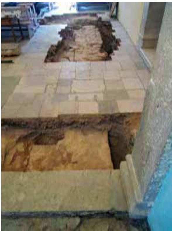
Sl. 5. Temelj sjeveroistočnog zida crkve sv. Luke iz 14. - 15. st.; u prednjem planu vidljiva je pravilnija linija koljena apside (foto: M. Tomasović) Fig. 5 Foundation of the northeast wall of the church of St. Luke from the 14th–15th c.; a more regular line of the apse bend is visible in the foreground (photo: M. Tomasović)
