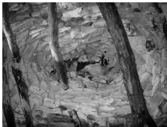
Prilog 3. (A) Uzastopni kameni slojevi pravilnog kružnog horizontalnog presjeka, po visini sve uži, tvore pseudokupolu Grizunova vrtujka u Češvinovoj (8). (B) Uzastopni kameni slojevi izrazito elipsastog horizontalnog presjeka, po visini sve uži, tvore izduženu pseudokupolu Ićotova vrtujka u Spiliškoj (13) Foto: Ivan Tabain (rujan 2020.)
