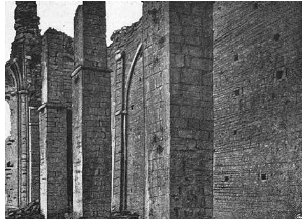
Sl. 10. Jugoistočni dio unutrašnjosti crkve; gravira prema Ippenovoj fotografiji (1899.). Vidljiv je četvrtstup kraj ostataka apside gornjega dijela srednjega broda te nagib krova na južnome brodu (30 stupnjeva)
