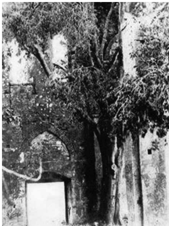
Sl. 37. Najstarija poznata fotografija unutarnjega dijela zapadnoga pročelja s prozorima i pilastrom na sjeverozapadnome stupu
