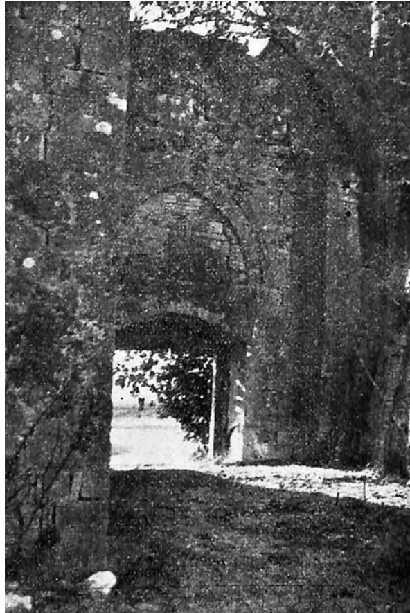
Sl. 23. Unutarnja strana zapadnoga pročelja. Vidljiva je stražnja strana lunete portala i rasteretni luk iza nadvoja s natpisom (izvor: Smirnov 1927.)
