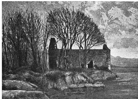
Sl. 16. Južno pročelje crkve. Gravira prema fotografiji koju je objavio Ippen (1899.) Fig. 16 South façade of the church. Engraving after the photograph published by Ippen (1899)
