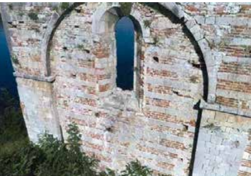
Sl. 31. Pogled na restaurirani prozor na južnome zidu (ispis slike iz snimke Terenca Pepe)
