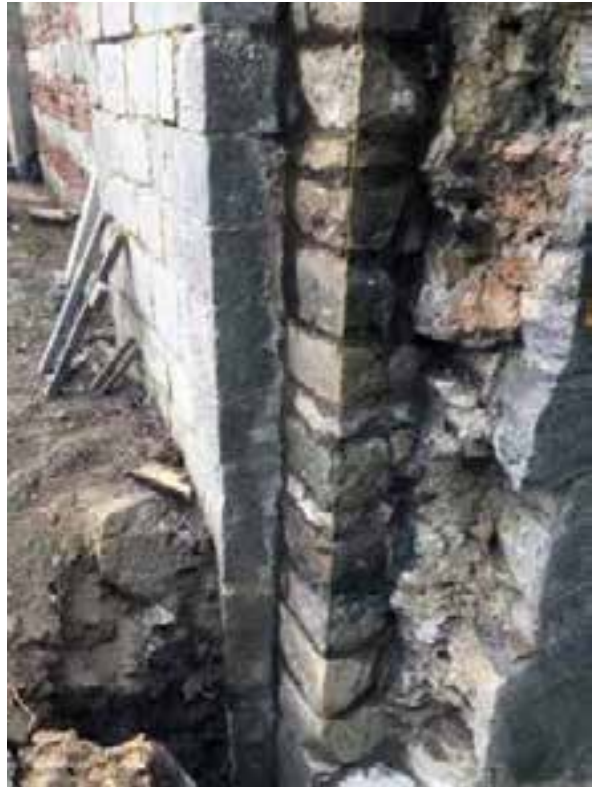
Sl. 35. Iskop rova uz južni portal (Helidon Sokoli)
