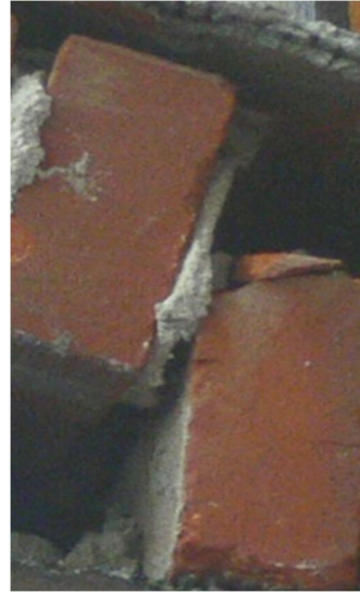
Slika 6. Smicanje spoja između cigli u kombinaciji s rotacijom, fotografija Ł. Bednarz
