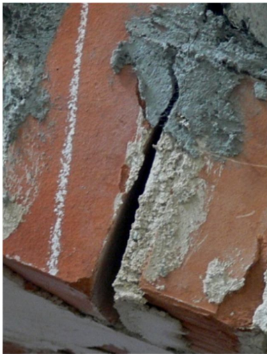
Slika 3. Stvaranje pukotine sa središtem rotacije u gornjem dijelu pukotine, fotografija Ł. Bednarz
