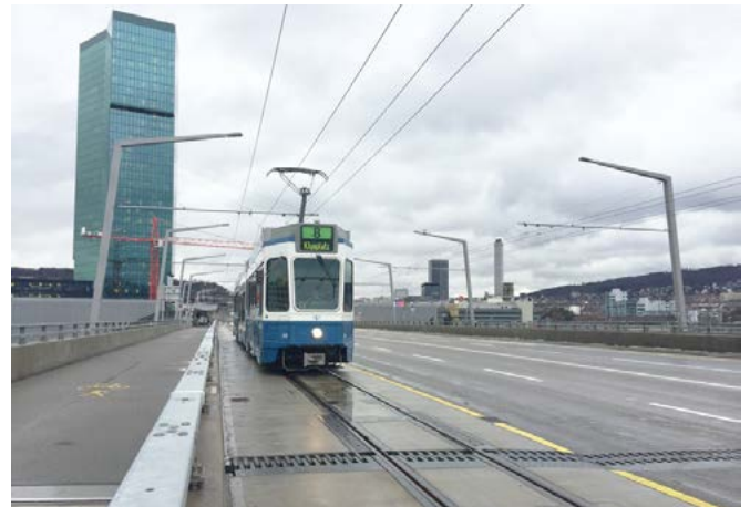
Slika 15. Uređaj za dilataciju žljebaste tračnice u Corkelast® Embedded Rail Systemu u kolniku
