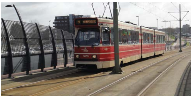
Slika 4. Corkelast® Embedded Rail System (sustav ugrađenih tračnica) na kolničkoj konstrukciji, u betonskome kanalu
