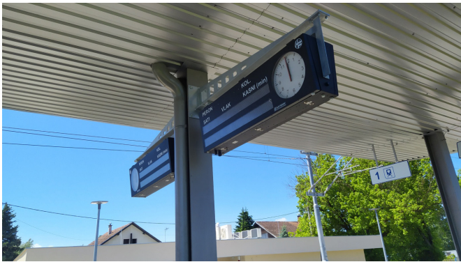
Slika 4. Primjer ugradnje kolosiječnih informacijskih ploča u kolodvoru Novi Dvori
