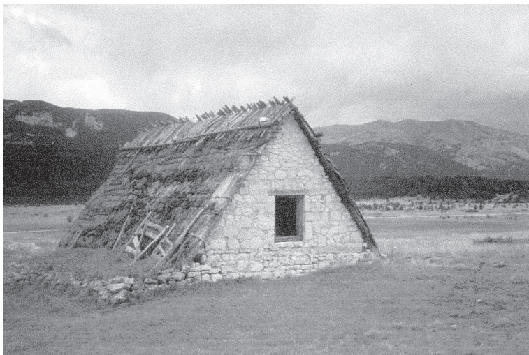
SL. 12. Tip staje s dvostrešnim krovistēm; sjeverno pročelje
