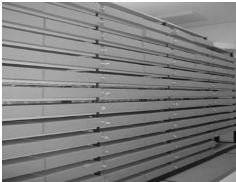
2. Smještaj parica u spremištu NAD-a
