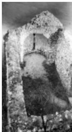
Sl. 16. Okić, burg, pogled na kapelu sa zidina
