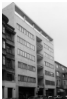
Sl. 43. Stambeno - trgovačka kuća Wellisch, Martićeva 13, D. Ibler, 1930/1931.
