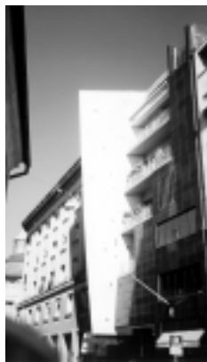
Sl. 53. Stambena zgrada, Petrinjska 9, M. Šosterič, 1995.
