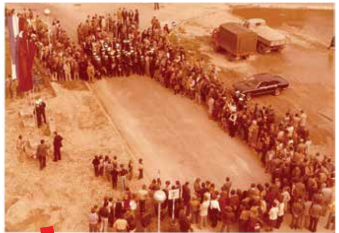
Polaganje kamena temeljca, 1979.
