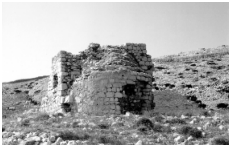
SL. 6. Crkva sv. Nikole, pogled na istočno pročelje s apsidom
