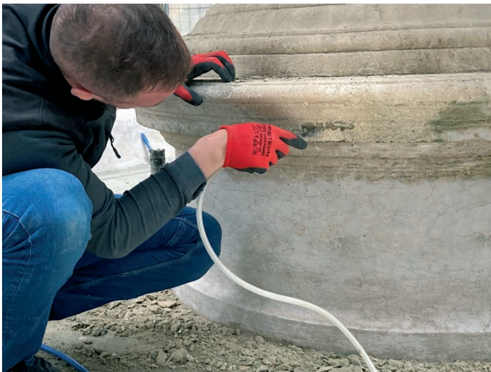
Slika 16. Uklanjanje kamenca mikrodlijetom
