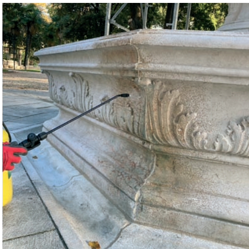
Slika 25. Nanošenje hidrofobne zaštite
