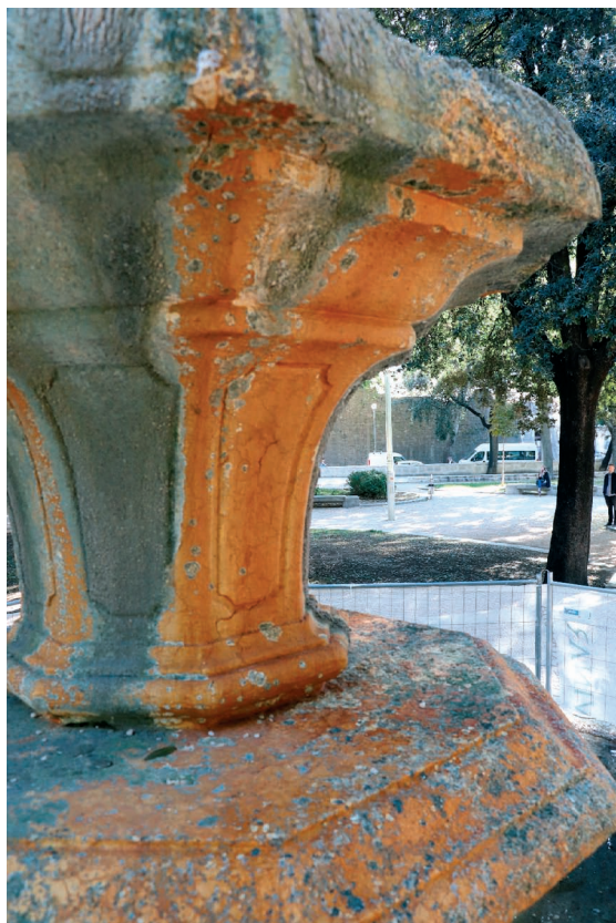
Slika 15. Tretiranje biocidnim sredstvom
