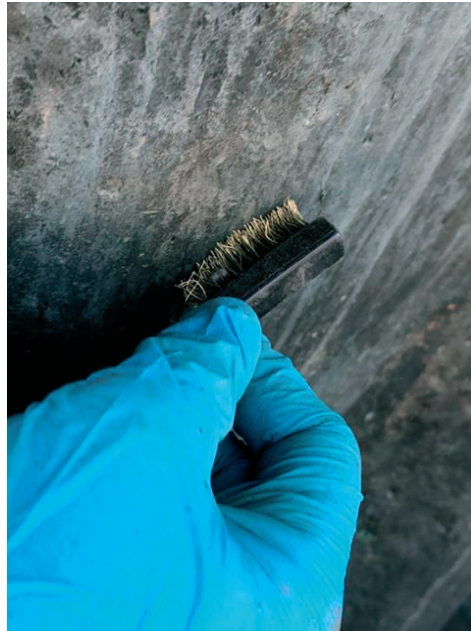
Slike 8-9. Pranje vodom pod kontroliranim pritiskom te mehaničko čišćenje ručnom alatkom
