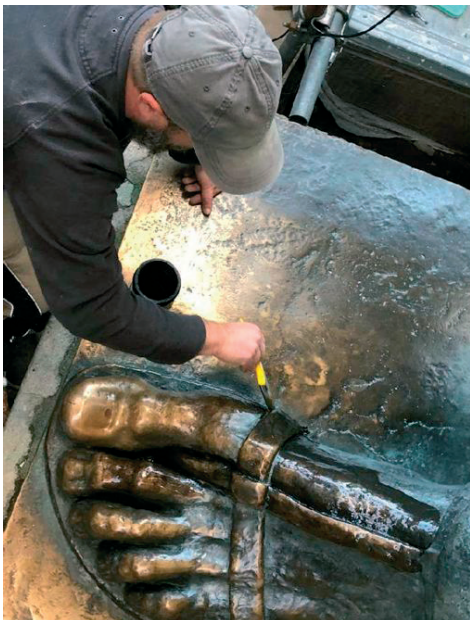
Slike 10-11. Proces patiniranja i nanošenje završne zaštite
