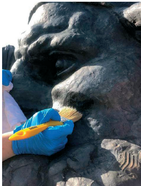
Slike 10-11. Proces patiniranja i nanošenje završne zaštite
