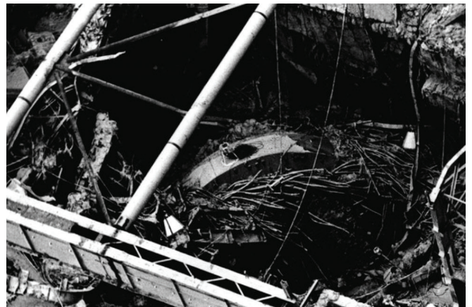
Slika 4 – Ruševine černobilskog reaktora fotografirane neposredno nakon havarije, na sredini fotografije vidljiva je struktura tzv. biološkog štita izbačenog iz reaktora 7
