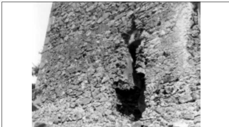
SL. 9. BURG RUŽICA NAD ORAHOVICOM, OSTACI ZAHODSKE KUĆICE NA ZAPADNOM PROČELJU PALAČE
