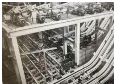
Slika 8 – Postrojenje za kontinuirano lijevanje čelika u Željezari Sisak
