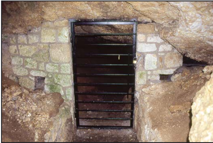
Nova rešetkasta vrata na ulazu u špiljski kanal foto: V. Božić
