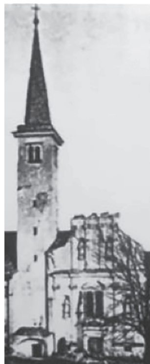
Slika 14: Pročelje pavlinske crkve nakon potresa
