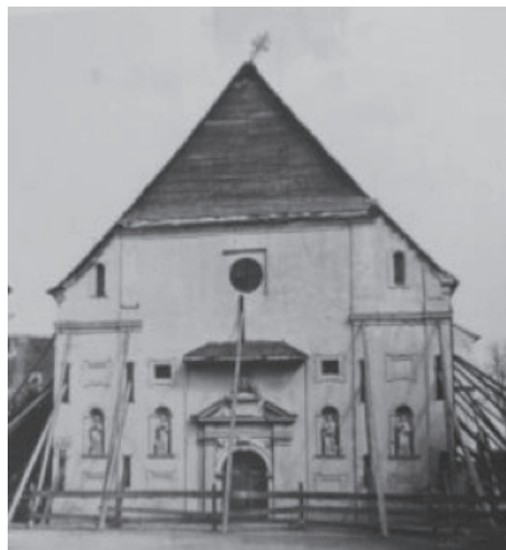
Slika 13: Pročelje isusovačke crkve nakon potresa
