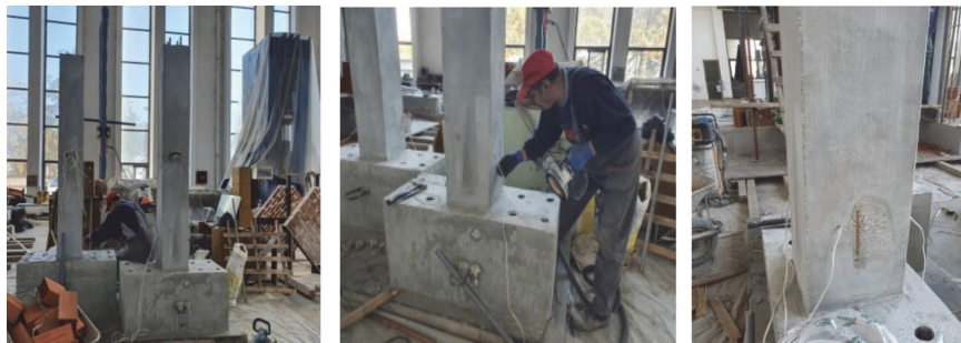
Slika 4. Fotografije snimljene tijekom nanošenja CFRP-a na modele i betonske valjke
