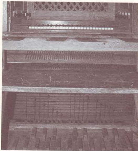
Slika 2. Ciglana (pogled na sviraonik i svirnu traktura s probodnicama). Na slici se vidi zračnica na kojoj je smješten fonički materijal manualnih i pedalnih registara te svirni prijenos, 2012.
