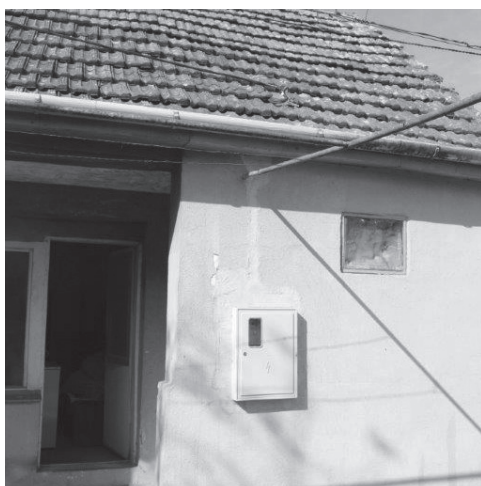
Slika 3. Priključak električne energije na objektu Figure 3. Connection of electric power on the building
