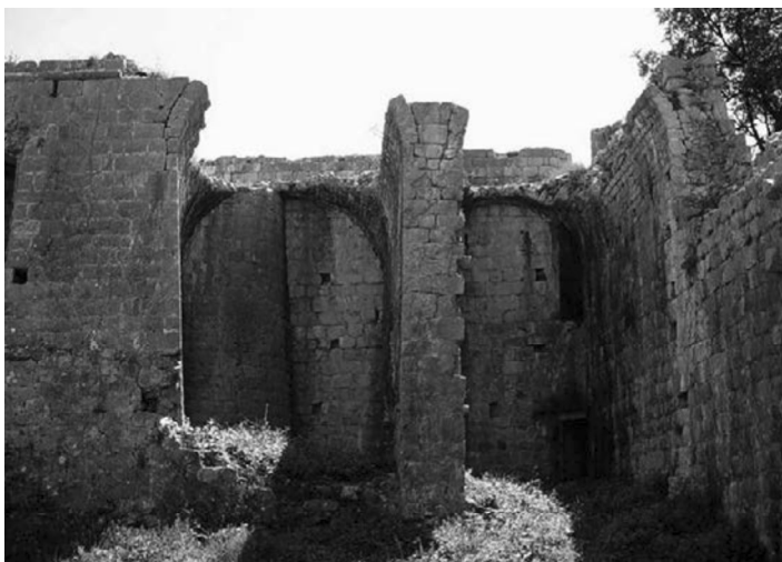
FRANJEVAČKI SAMOSTAN I UTVRDA GOSPE OD ŠPILICA NA LOPUDU, ZATEČENO STANJE; IZVOR: ARCUS DALMATIA
