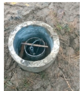
Slika 11. Ukopano vertikalno anodno ležište
