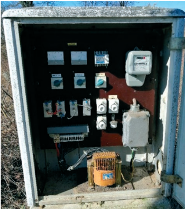
Slika 8. Napojna stanica s ručnom regulacijom
