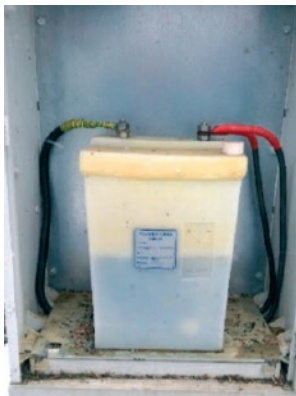
Slika 13. Polarizacijska ćelija s kalijevom lužinom
