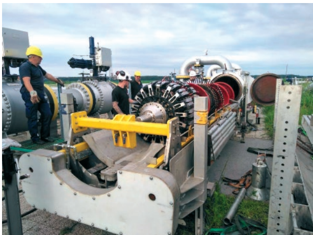
Slika 6. Odašiljanje MFL alata na plinovodu promjera DN800
