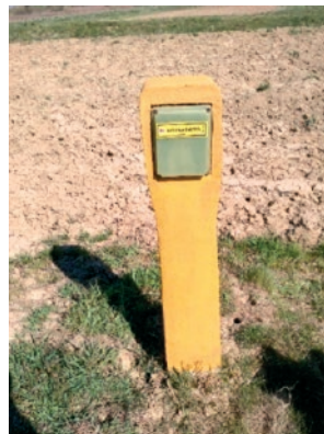
Slika 15. Betonsko mjerno mjesto
