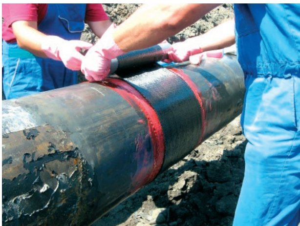
Slika 26. Popravak oštećenja postavljanjem kompozitne obujmice
