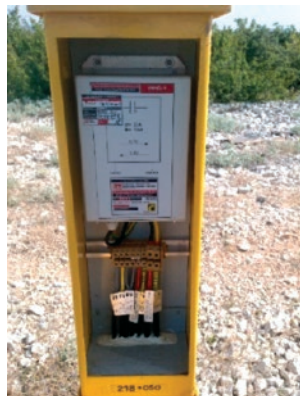
Slika 14. Poluvodička polarizacijska ćelija
