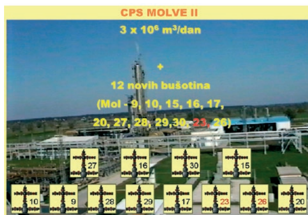
Slika 6. Centralna plinska stanica Molve II
