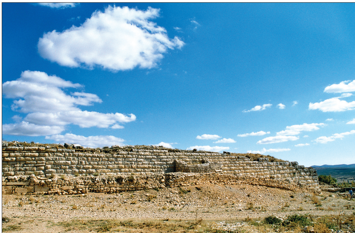
Sl. 1. Pogled na zapadni pravac kasnorepublikanskog bedema i kasnoantičkog zida. Fig. 1. View at the western line of a late-Republican fortress and late-Antiquity wall.
