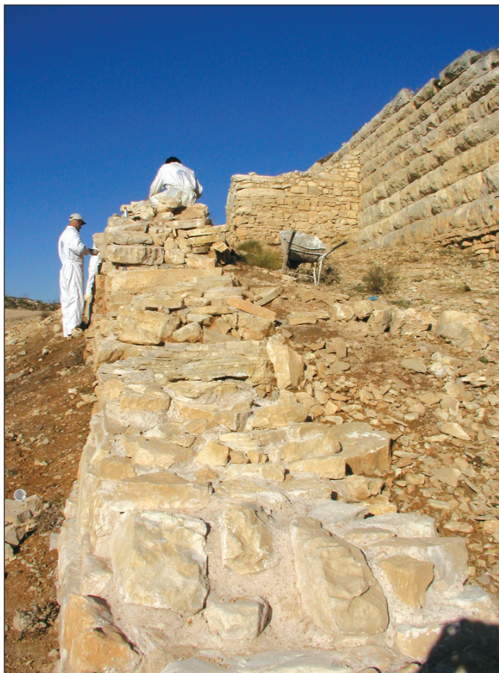
Sl. 2. Konzervatorski radovi na kasnoantičkom zidu
