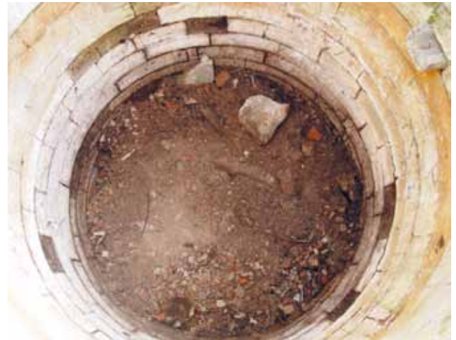
SLIKA 5. Središnji spremnik za vodu (SJ 005 (004); Arhiv terenske dokumentacije Novigrad na Dobri).
