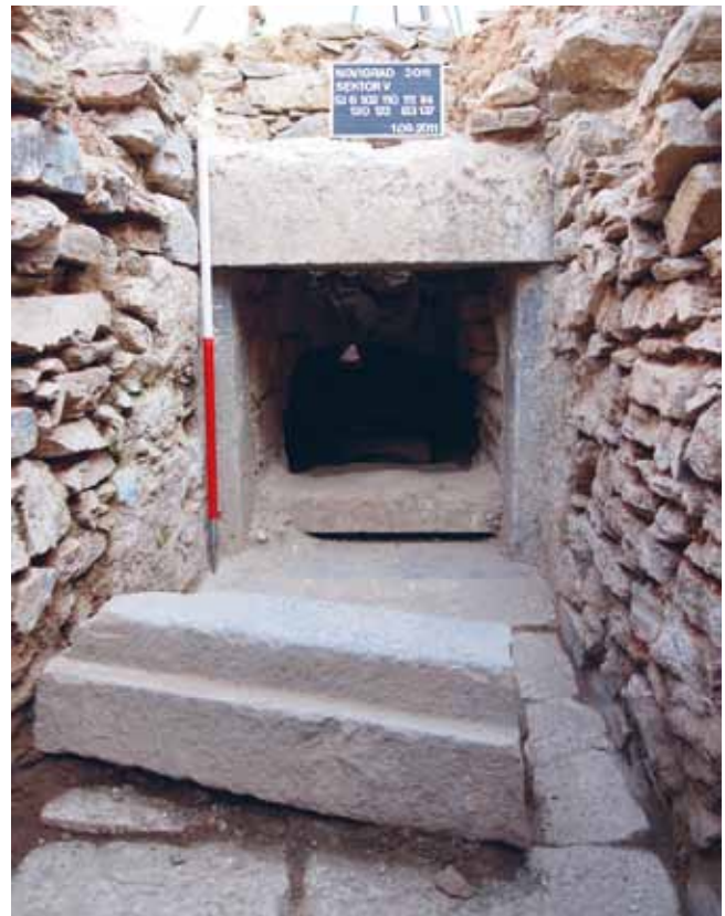
SLIKA 17. Ulaz u tunel (Arhiv terenske dokumentacije Novigrad na Dobri). FIGURE 17. Draft of the tunnel entrance (Excavation documentation archives, Novigrad na Dobri).
