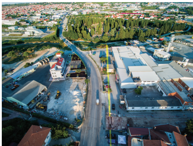
Slika 7. Novootkriveni kanal rimskog akvedukta – trasa podzemne dionice kod Gradskog groblja
